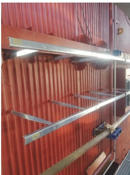
Slika 3. Pod-konstrukcija generatora pare
