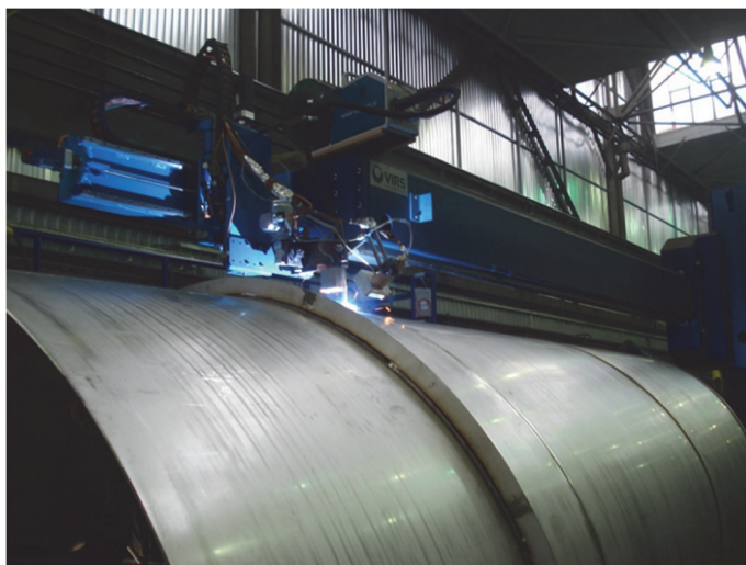
Slika 10. Zavarivanje jedne polovice spremnika u napravi
