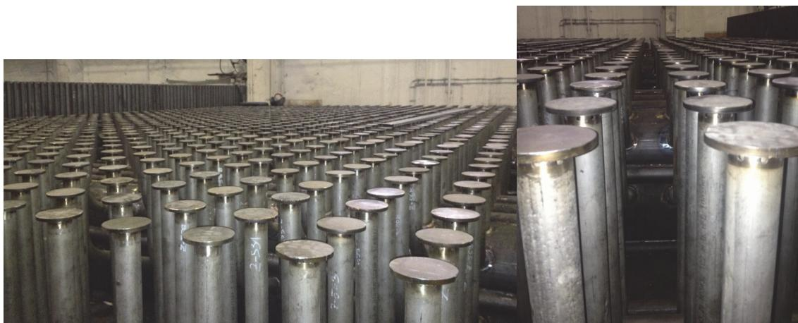
Slika 17. Zavareni i nivelirani priključci zraka
