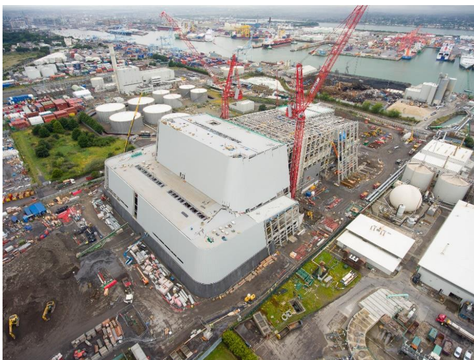
Slika 2 Gradilište u Dublinu (Irska) [2].
