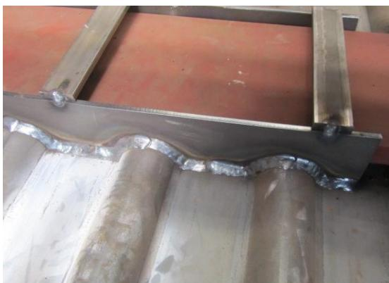
Slika 1. Zavarivanje FCAW češljastih limova na membranske zidove kotlovnog postrojenja
