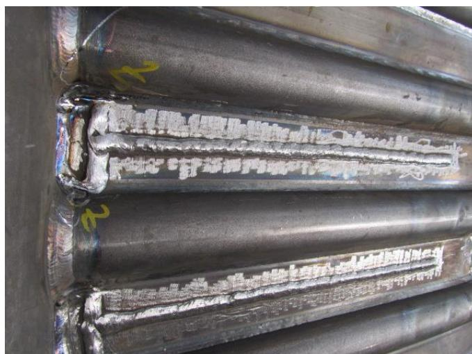
Slika 6 Spojevi brušeni u svrhu uklanjanja površinskih nepravilnosti nakon FCAW zavarivanja „šliceva“ na membranskim zidovima
