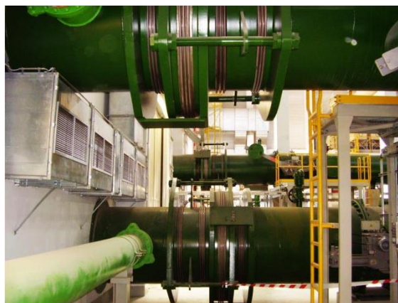
Slika 7b Aksijalni spregnuti kompenzator opterećen unutarnjim tlakom [6]
