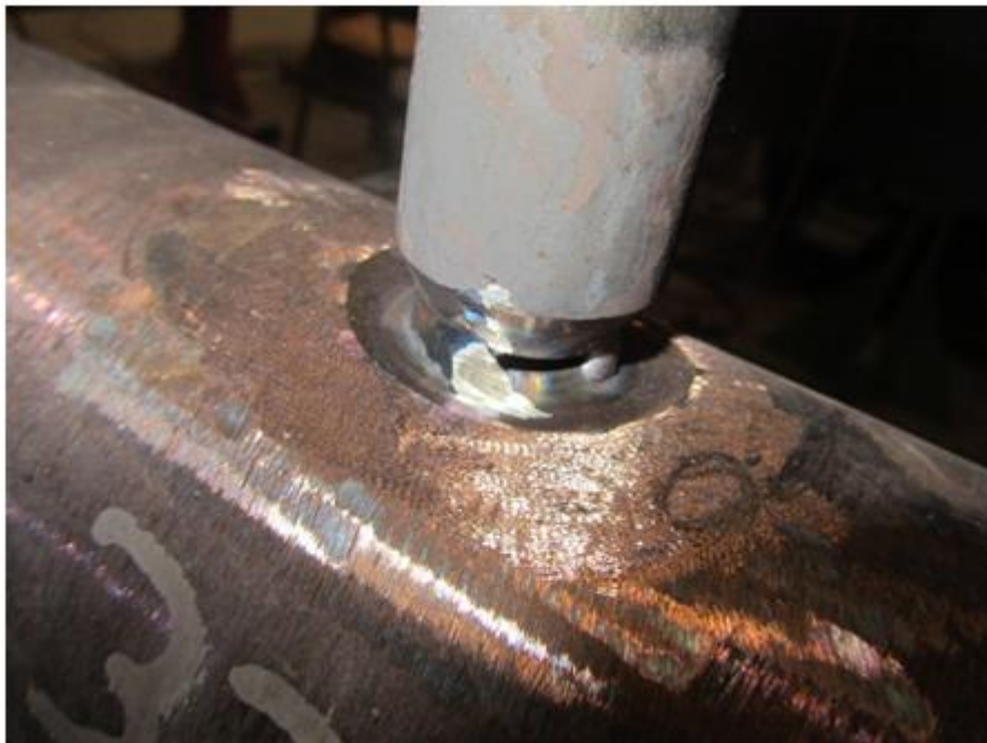
Slika 11. Priprema mjesta spoja u korijenu zavara
