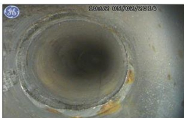
Slika 11. EVT fotografija brušenog korijena cijevi
