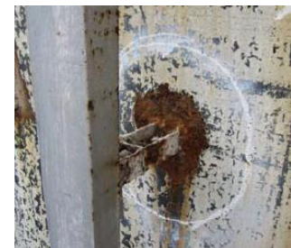
c) Piting korozija u zoni lošeg spoja (plašt)
