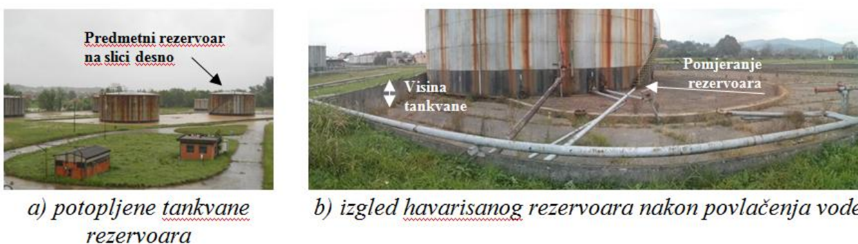
Slika 5. Primjer preopterećenje u toku poplava i havarija rezervoara (BiH, 2014)
