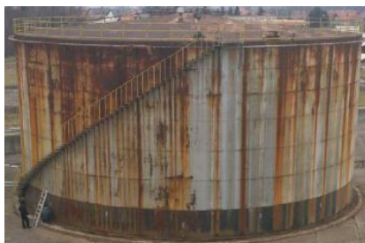
a) Teško korodirani krov i plašt rezervoar (krov bez zaštitnih premaza)
