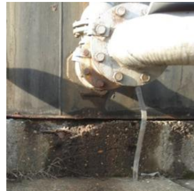
b) Primjer oštećenja betonskog temelja i tragovi curenja – indikacija proboja podnice
