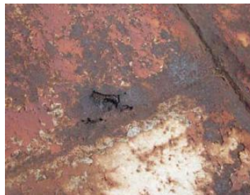
b) Proboji uslijed korozije u zoni lošeg spoja (krov)
