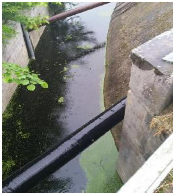
*Slika 2. Instalacija plinovoda u betonskom pokosu kanala*
