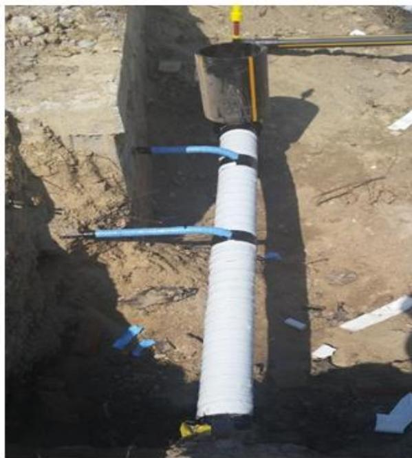
*Slika 10. Antikorozivna zaštita cjevovoda*
