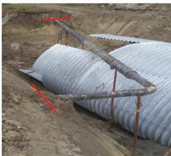
*Slika 8. Točke presjecanja plinovoda*
