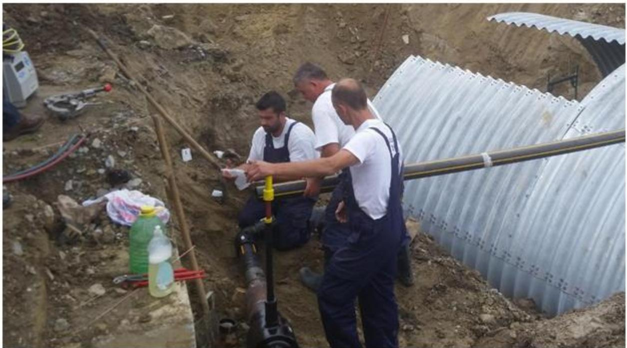
*Slika 9. Priprema za elektrofuzijsko zavarivanje*
