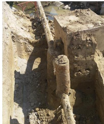
*Slika 4. Zaporni ventil plinoopskrbe DN 100*
