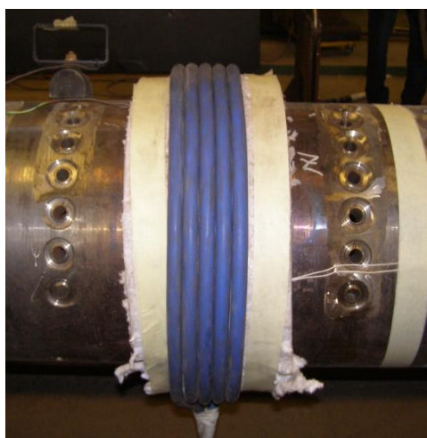
Slika 4. Lokalna toplinska obrada sučeljenog spoja na komori
