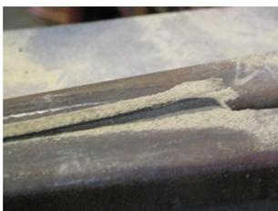
Slika 5: Otklanjanje troske kod zavarivanja tračnica
