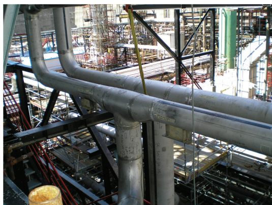
Slika 10: Zavarene linije dupleks cjevovoda
