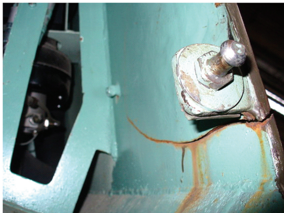
Slika 25. Pukotina na LOV-u s unutarnje strane
