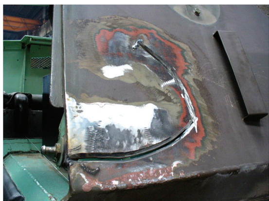
Slika 27. Priprema za zavarivanje
