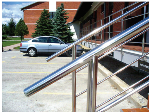
Slika 32. Spoj cijevi na rukohvatu
