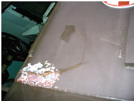
Slika 26. Pukotina s vanjske strane
