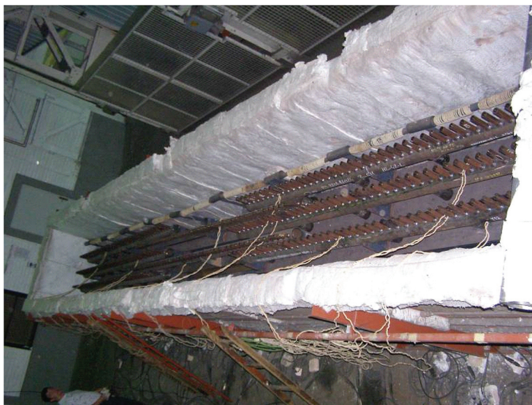
Slika 6.1: Odžarivanje komora nakon zavarivanja priključaka u peći
