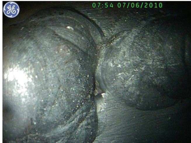
Slika 5.3: Greška vezivanja u korijenu zavora, spoj priključak komora, materijal P91, projekt Mellach
