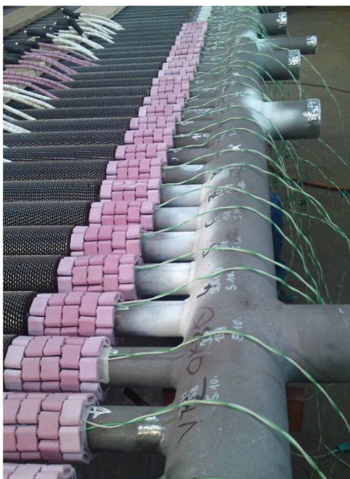
Slika 4.1: Predgrijavanje elektrootpornom metodom sučeljenih spojeva priključak – cijev harfi
