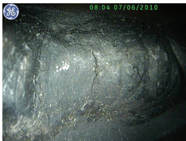
Slika 5.2: Oksidacija korijena zavara, spoj priključak-komora, materijal P91, projekt Mellach
