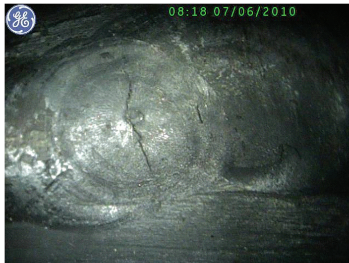
Slika 5.4. Pukotine u završnom krateru korijena zavora, spoj priključak-komora, materijal P91, projekt Mellach
