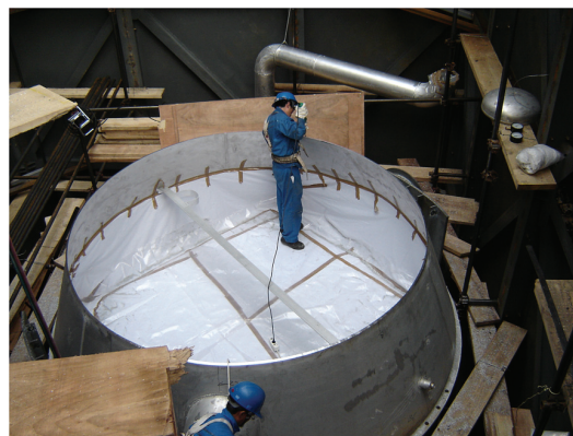
Slika 4. Priprema žlijeba na donjem dijelu stupca
