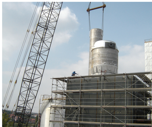
Slika 2. Donji dio stupca postavljen u Cold box
