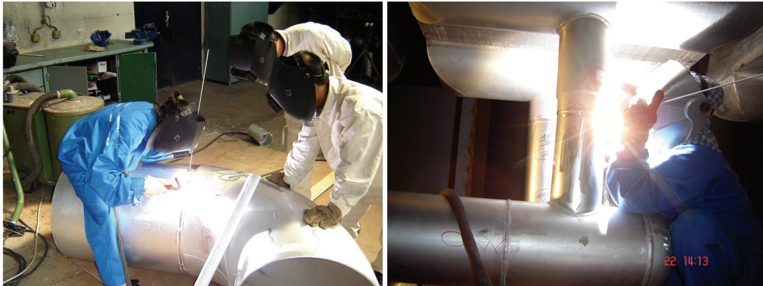
Slika 7. Zavarivanje dijela cjevovoda u radionici Slika 8. Zavarivanje montažnog spoja na cjevovodu
