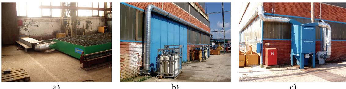
Slika 3. Elementi odsisa dimnih plinova na CNC rezačici
