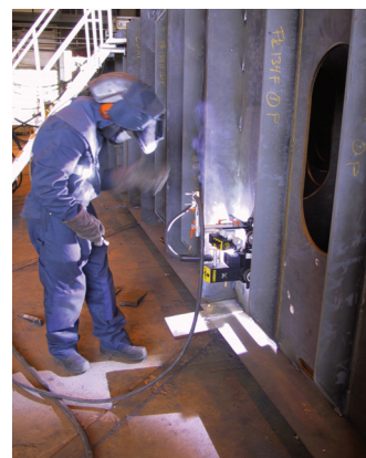
Slika 4. Zavarivanje vertikalnog kutnog zavara
