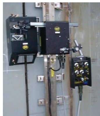
Slika 8. Vertikalno zavarivanje uz pomoć letve
