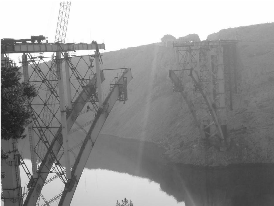
**Izvođenje zavarivanja pri specifičnim montažnim uvjetima na Masleničkom mostu**
