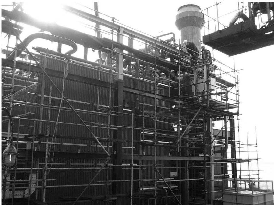
Praktična primjena stečenih znanja osposobljenih zavarivača pri izvođenju montažnih zavara na složenom kotlovskom postrojenju
