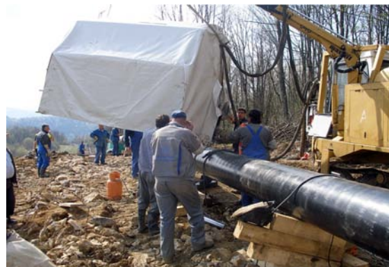
Slika 9. Priprema za zavarivanje
