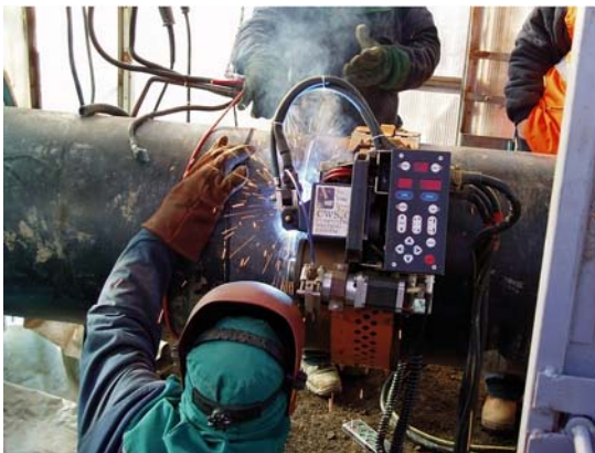
Slika 3. Glava za zavarivanje
