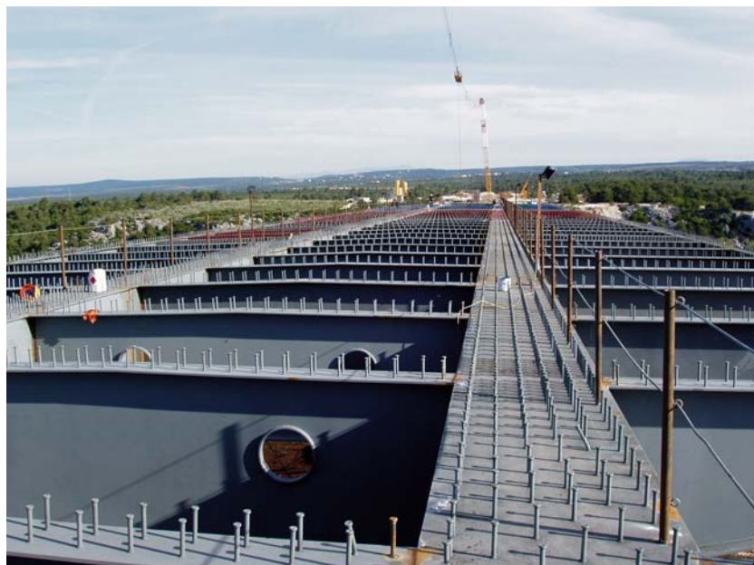
Slika 4. Primjer uspješno zavarenih moždanika na elementima mosne konstrukcije
