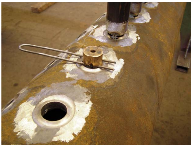
Slika 4 Postavljanje priključaka uz korištenje naprave
