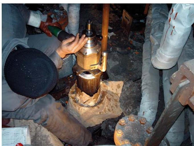
Slika 7. Strojna priprema za zavarivanje na objektu
