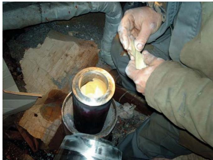
Slika 5. Izrada pregradne komore u cijevi na objektu
