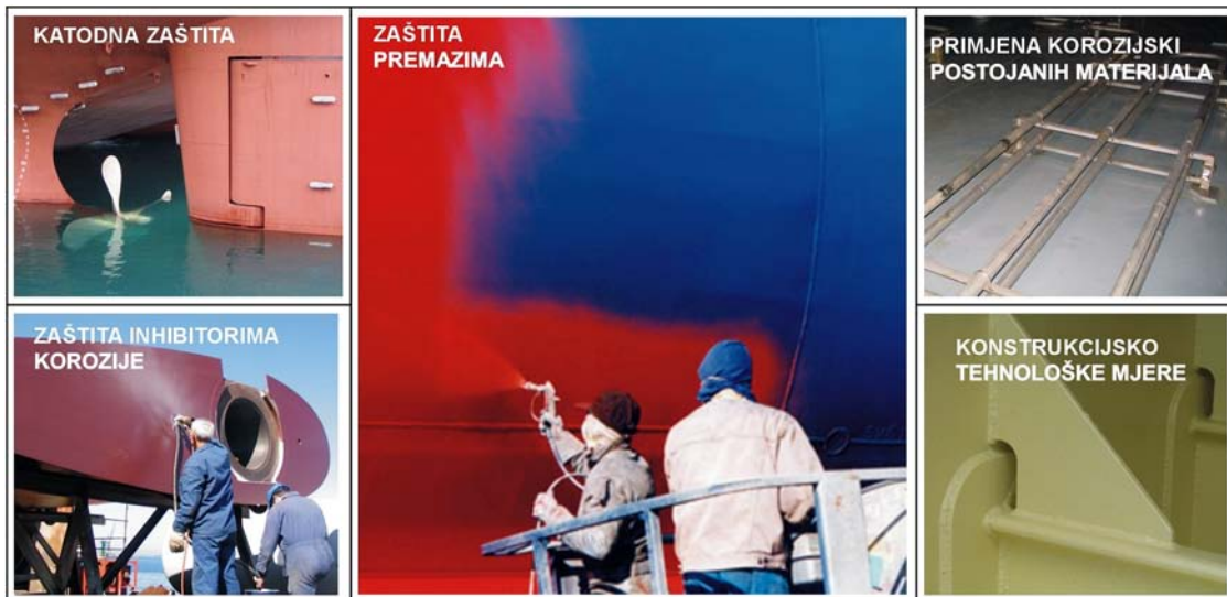
Prikaz 1. Metode zaštite od korozije
