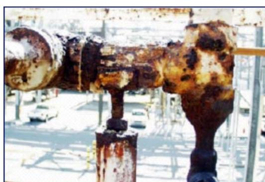
Slika 5. Korozija ispod izolacije [3]
