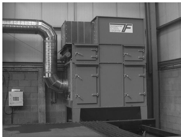
Slika 3. Filter za pročišćavanje plinova, para i metalne prašine nakon odsisavanja s odsisnog stola, kojim se omogućuje vraćanje zraka u radionicu
