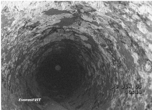
Slika 14. Korozija i sublimat u dimovodnoj cijevi
