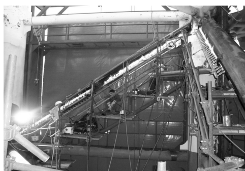
Slika 8. Predgrijavanje postavljenih gredica
