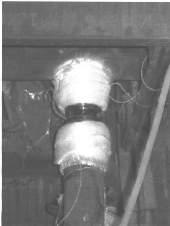
Slika 4: Priprava zvarnega mesta na vertikalnemu kolektoru
