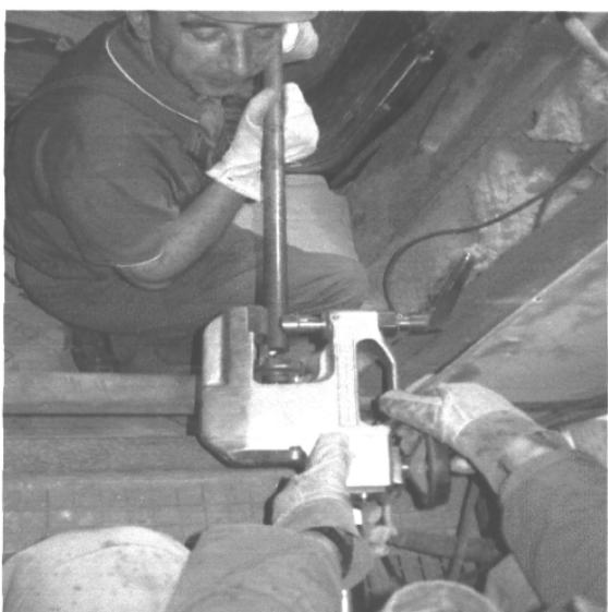
Slika 5: Priprava zvarnega mesta na membranski steni s pnevmatisko napravo
