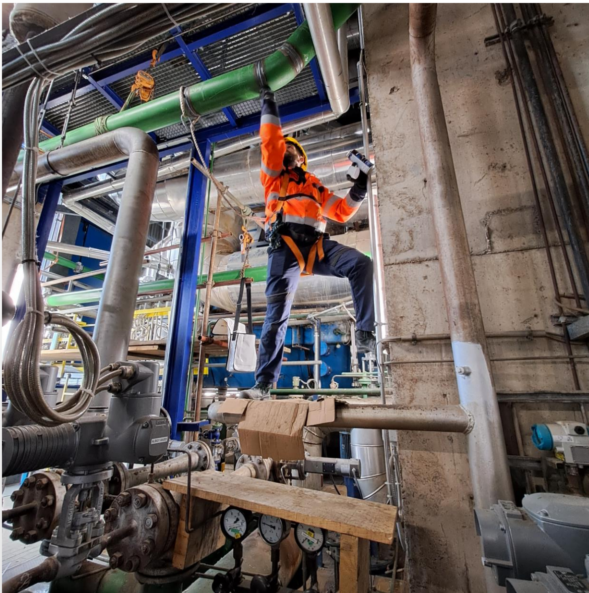
Marko Zovko, Mijat Samardžić - Sanacija pukotine na čeonj stijeni mlina sirovine - Iskustva iz prakse i suvremeni postupci zavarivanja - 22.11.2022.
