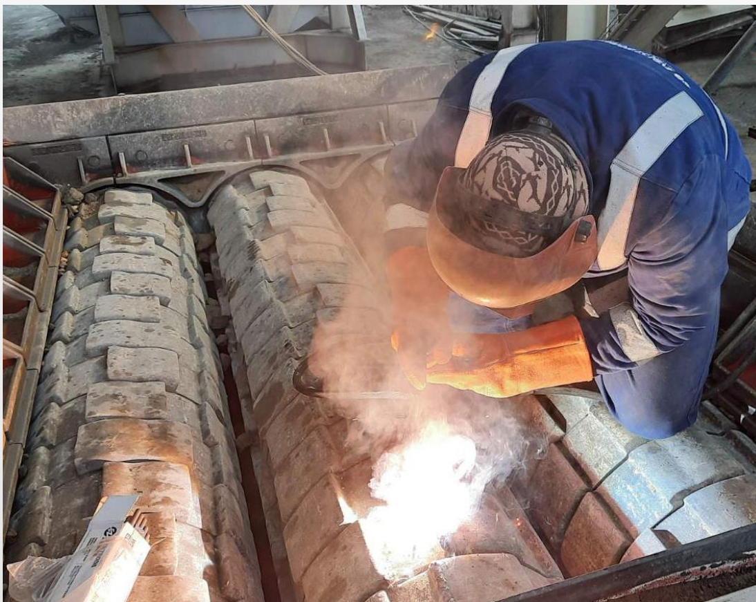
Marko Zovko, Mijat Samardžić - Sanacija pukotine na čeonj stijeni mlina sirovine - Iskustva iz prakse i suvremeni postupci zavarivanja - 22.11.2022.
