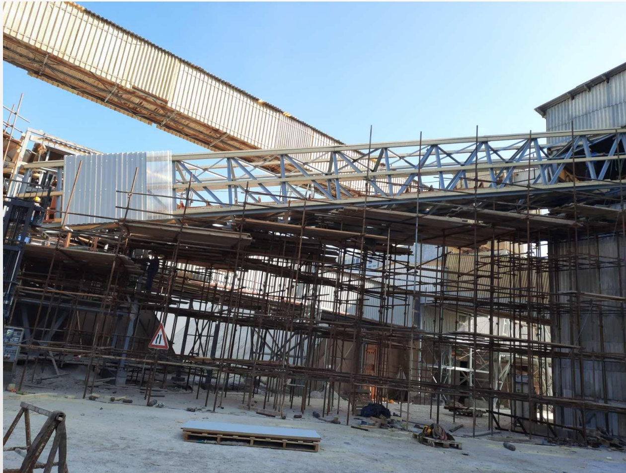
Marko Zovko, Mijat Samardžić - Sanacija pukotine na čeonj stijeni mlina sirovine - Iskustva iz prakse i suvremeni postupci zavarivanja - 22.11.2022.
