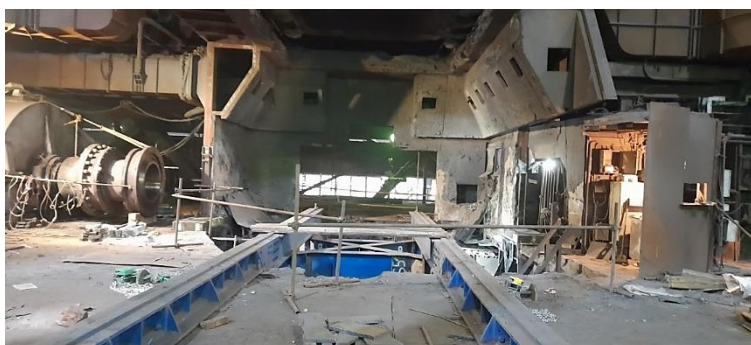
Slika 7. Priprema mjesta za montažu kiseonikovog (BOF) konvertora
