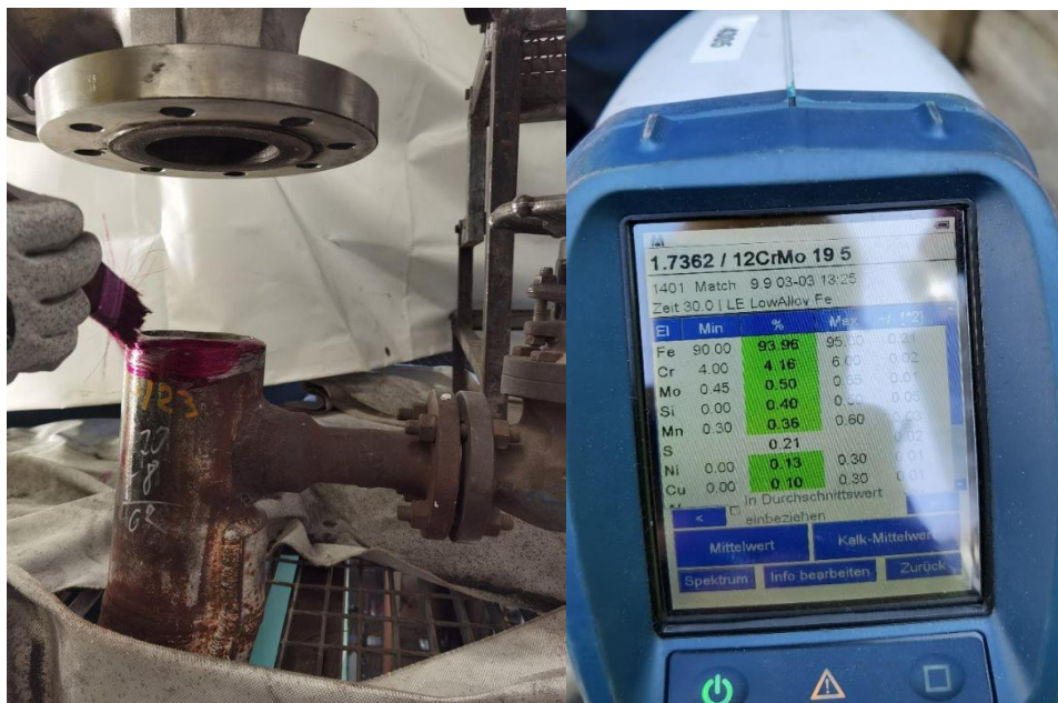
Slika 11. a) Ispitivanje penetrantima prije zavarivanja b) PMI ispitivanje
