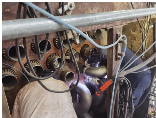
Slika 7. Zavarivanje na peći TIG postupkom
