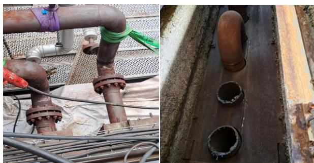
Slika 2. a) i b) Rezanje postojećih pozicija
