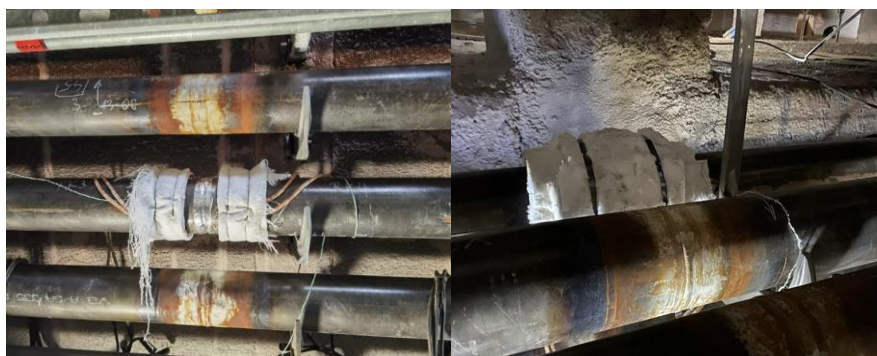
Slika 12. a) Grijači za održavanje temperature b) Toplinska obrada X12CrMo9-1 (P9)
