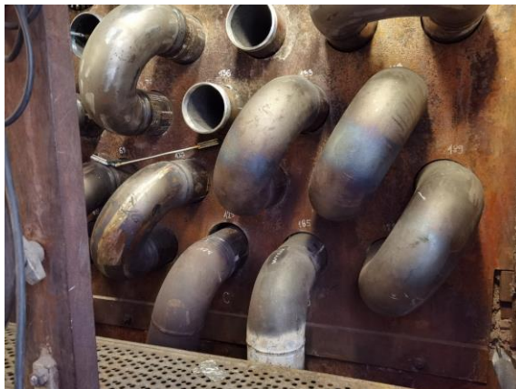
Slika 6. Montaža novih cijevi u peć
