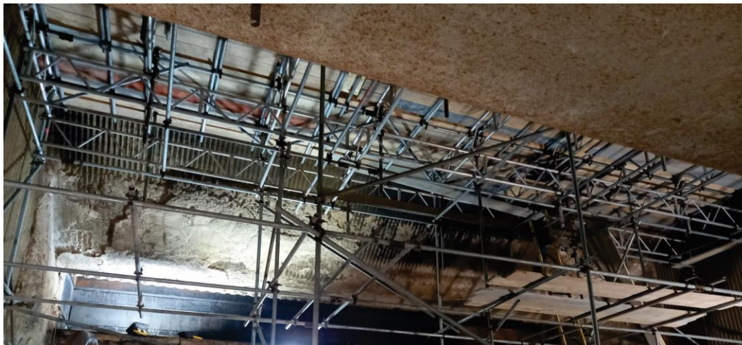
Slika 4. Pogled na stanje izolacije zidova ložišta prije izvođenja radova
