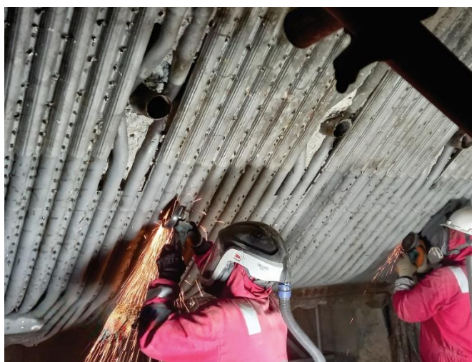
Slika 6. Odrezivanje nosača izolacije V- tipa sa zida ložišta
