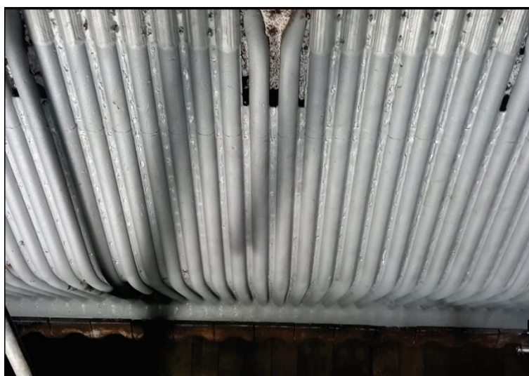
Slika 8. Pripremljena površina zida za navarivanje
