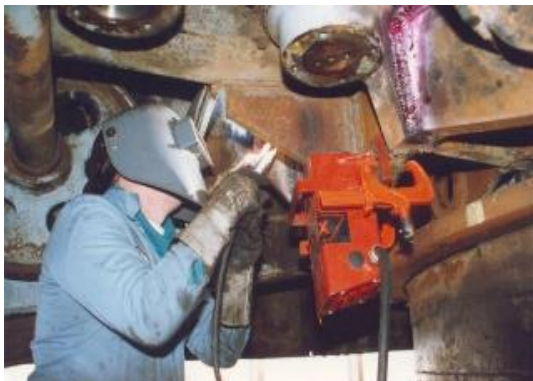
Slika 1. Korištenje VSR metode kod sanacije čeličnih konstrukcija
