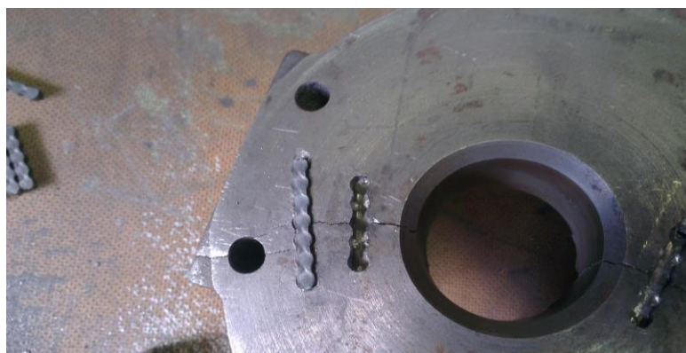
Slika 6. Postavljanje METALOCK ključeva. [2]
