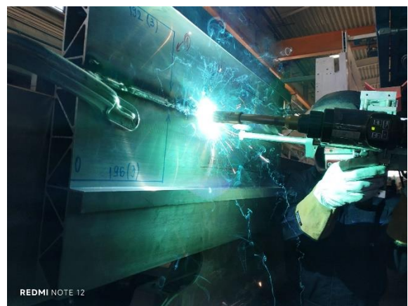
Slika 4. Izgled lica šava u toku zavarivanja preko veštački unetih reflektora
