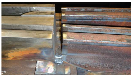
Slika 4 Priprema za zavarivanje šape III prolaz
