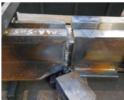
Slika 8 Izgled spoja šina-blok pre navarivanja
